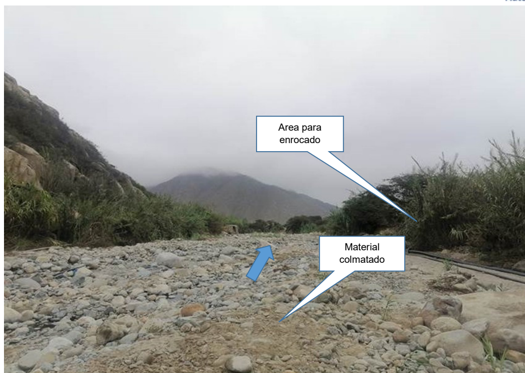
FIGURA N°02: : TRAMO CRÍTICO, A 50m DEL PUNTO DE INICIO AGUAS ABAJO CON VISTA AGUAS ABAJO, MATERIAL COLMATADO.
